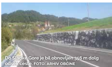
Obnova odseka Cerovec–Sveti Štefan je v zaključni fazi. FOTO: ARHIV OBČINE
